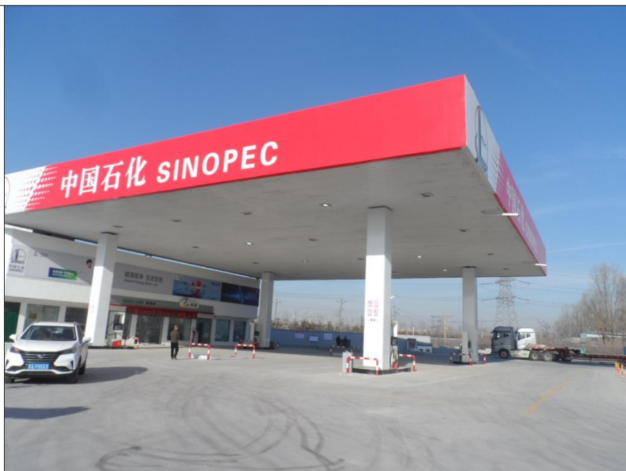
现场勘察图片
