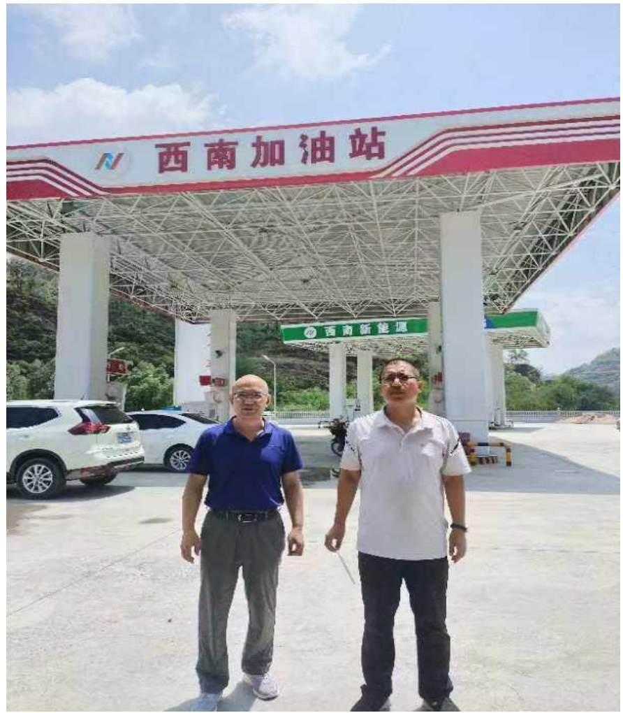
现场勘察图片
